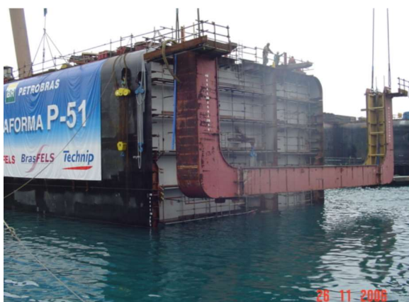
Foto da instalação do coferdan
