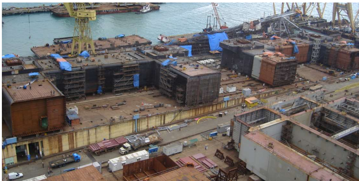
Fotos das movimentações alternadas dos blocos (NUCLEP e Singapura) do pontoon.
