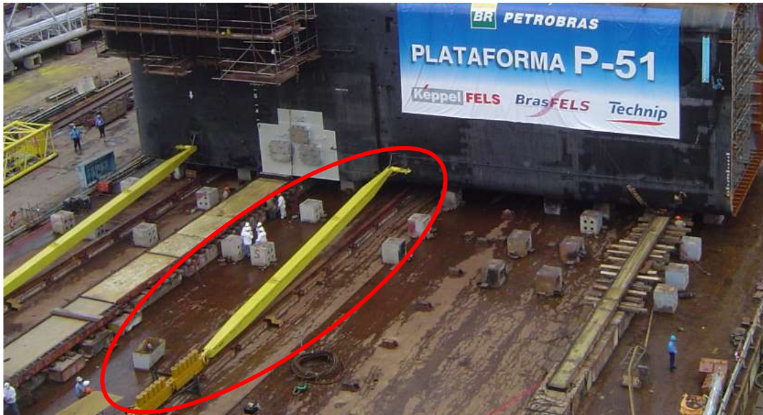
Foto do lançamento - skidamento do casco
