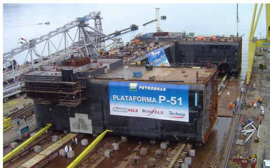
Foto do início do lançamento da metade do pontoon.
