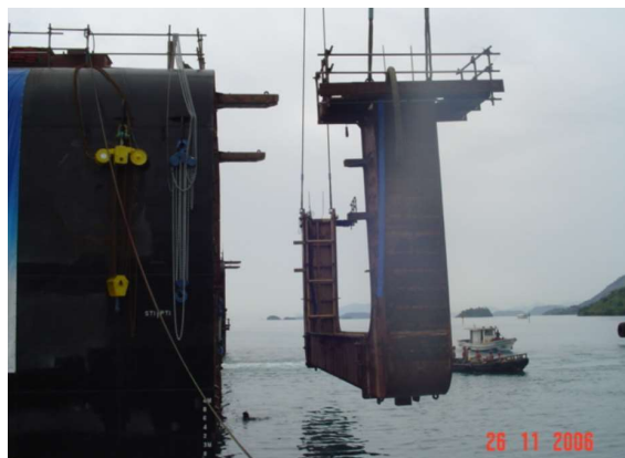
Foto do coferdan construído
