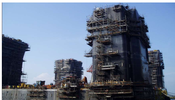
Foto das colunas edificadas no pontoon.
